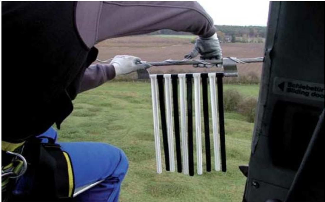
**Abb. 16:** Beispiel für das Anbringen von Vogelmarkern (Markierung aus beweglichen schwarz-weißen Kunststoffstäben auf einer Aluminium-Trägerkonstruktion, Fotos von RWE Rhein-Ruhr AG in: T. Müller, Langewehe (2007) in: Der Vogelfreund H. 7, 2007)
