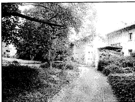
Bild 3: Zugang zum Schulgebäude
